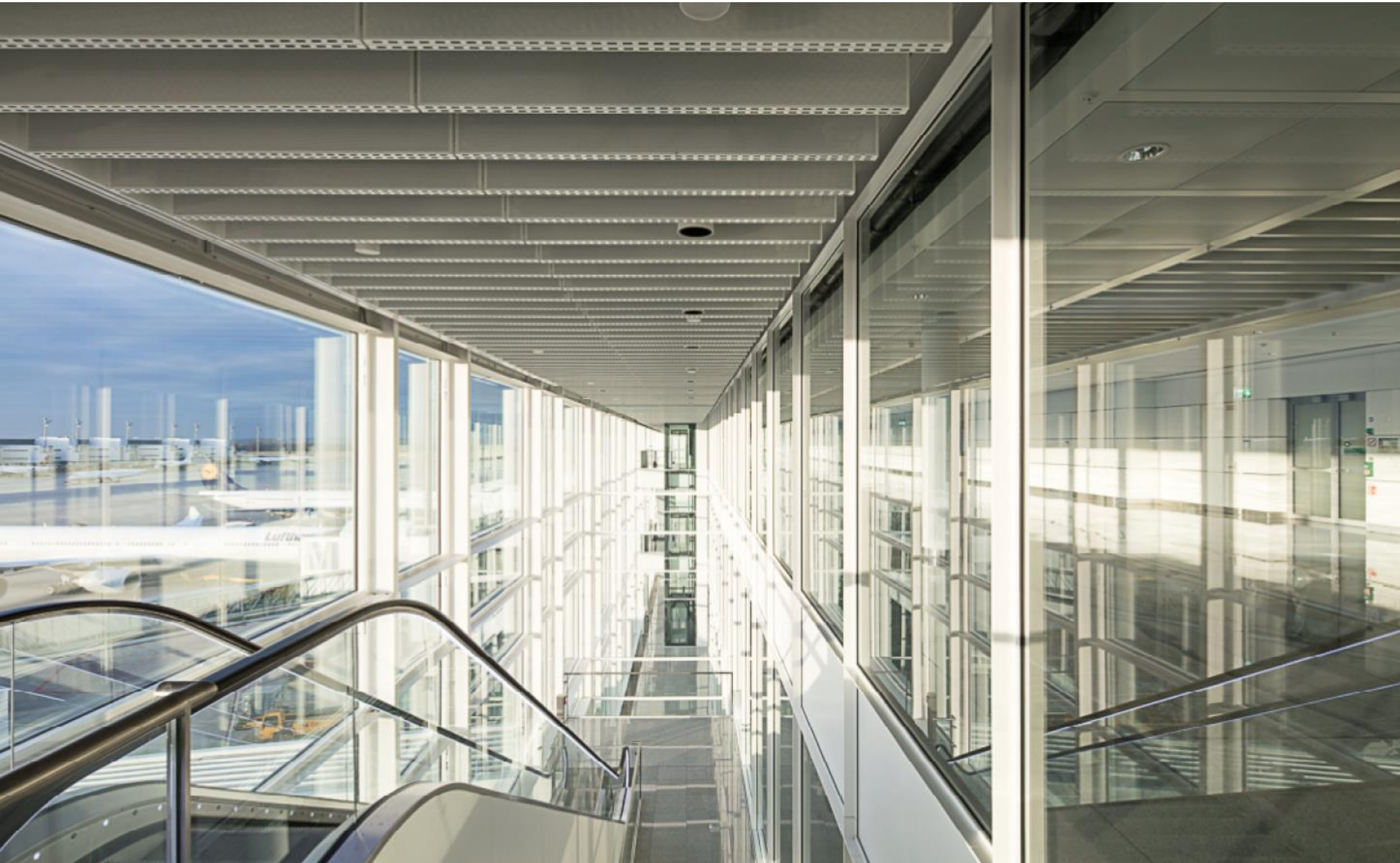
Flughafen München – Satellitenterminal – Klimafassade
